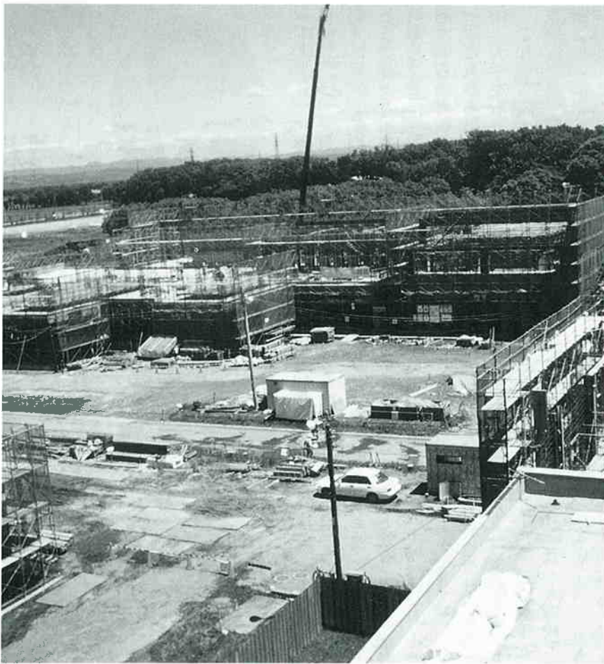
〈建築中の大学棟〉
